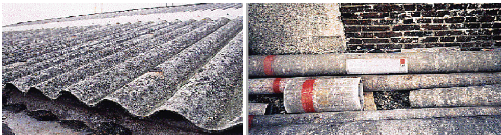
Слика бр. 13. Азбест-цементни кров и азбест-цементне цеви
