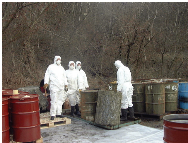
Слика бр. 35. Припрема и паковање опасног отпада на прописани начин и мере заштите
